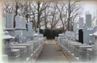
通路は水はけのよいアスファルト舗装とし、歩きやすくなっております。
